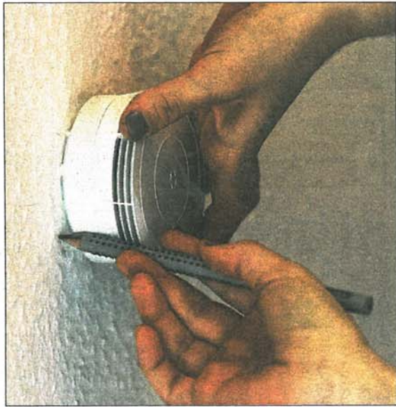
Eine Frau zeichnet an der Decke die Position für einen Rauchmelder an. Foto: Patrick Seeger, dpa
